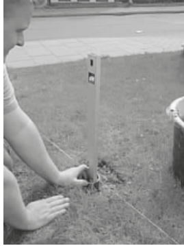
Ausrichten mit Wasserwaage
