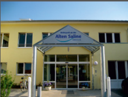
Leuchtransparent, eingepasst im Vordach
