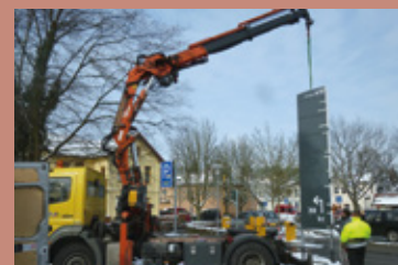
Montage eines Pylons
