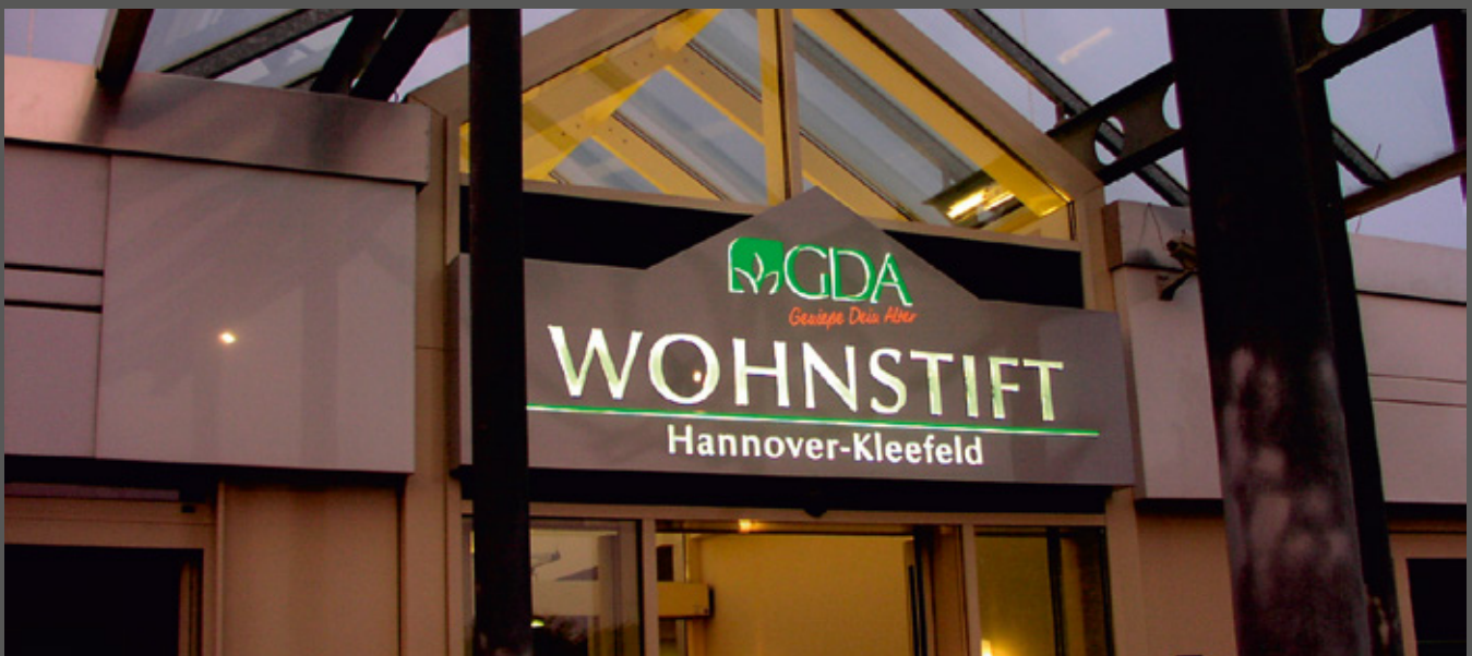
Leuchttransparent, Aluminiumgehäuse, silber lackiert. Buchstaben ausgelasert, mit Acrylglas hinterlegt und zusätzlich durchgesteckten 10 mm Einzelbuchstaben.
