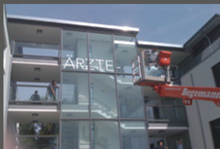
25l Montage einer Fassadenbeschriftung
