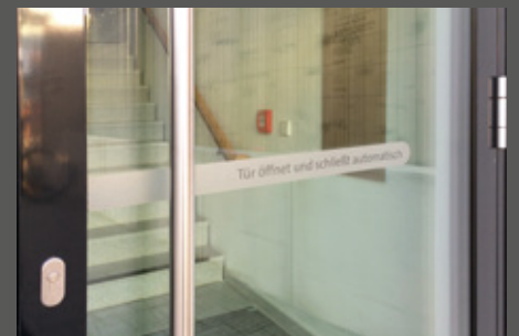
121 Hinweis auf Automatiktür
