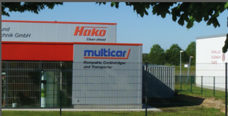
Fassadenlogos, 3 mm Dibond, verklebt auf Fassade
