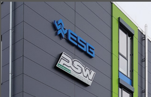
151 Leuchtwerbung an Fassadenelementen
