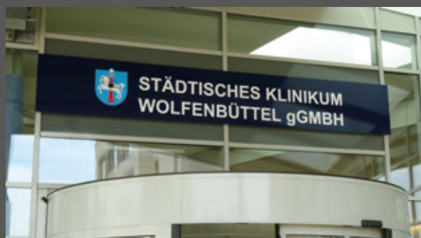
101 Schild mit Unterkonstruktion auf Glasfassade
