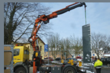
Montage eines Pylons
