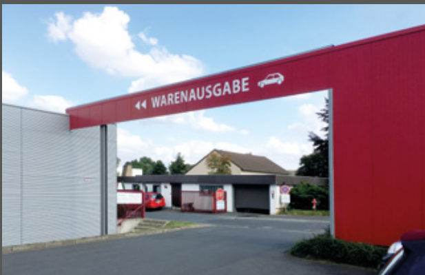
141 Folienbeschriftung auf Aluminiumfassade
