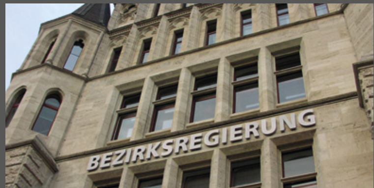
Einzelbuchstaben Aluminium, 60 mm Zargentiefe, mit Abstand montiert
