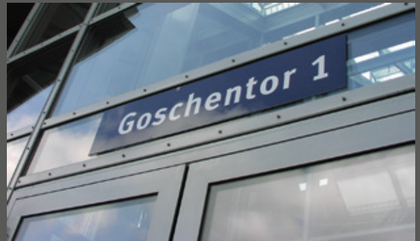
20l Gebäudeadresse in der Fassade integriert
