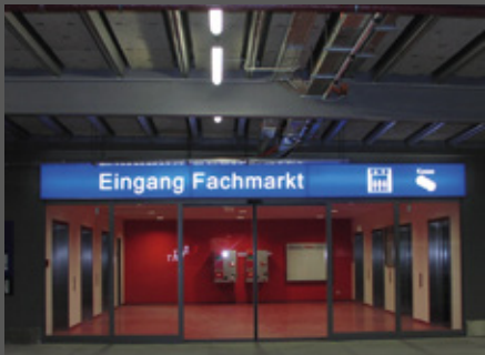
11 Leuchttransparent zur Eingangskennzeichnung
