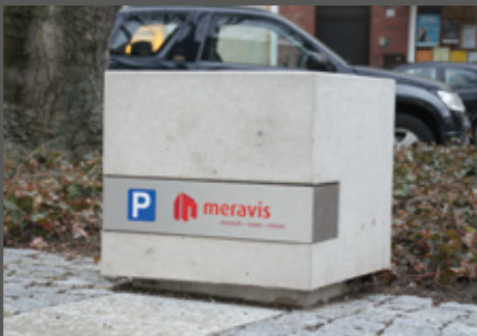
111 Schild Edelstahl, eingelassen in Betonblock
