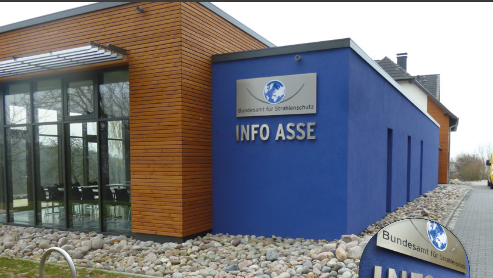
Fassadenlogo, äußerst wertige Edelstahlbuchstaben 30 mm Zargentiefe, mit Abstand montiert
