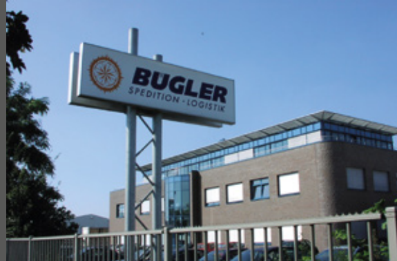
21l Gittermast mit beidseitigem Leuchttransparent
