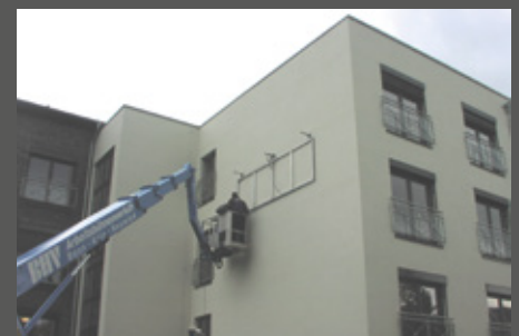
26l Montage einer Fassadenwerbung
