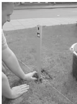
Ausrichten mit Wasserwaage
